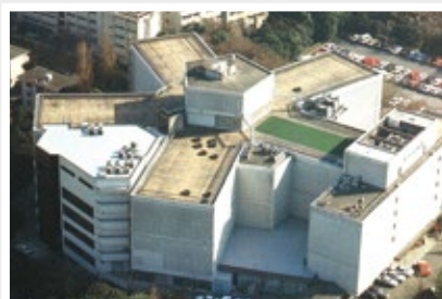
別館増築 財団創立20周年、開館15周年記念事業（地階～2階）、財団創立30周年、開館25周年記念事業（3階～5階）として別館（写真左下部分）を建設。1988年11月に別館全フロアが完成した
