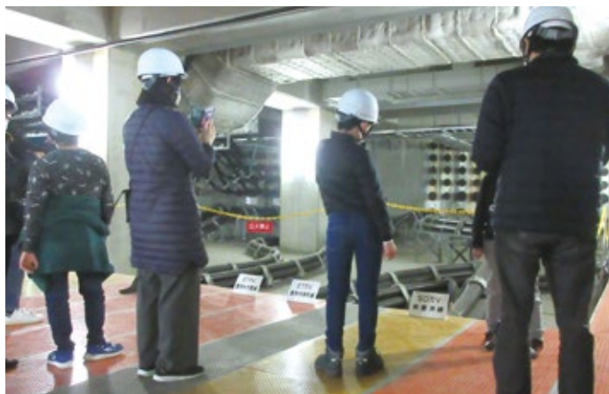
世界最大規模の地下変電所「新豊洲変電所」で CV ケーブルを見学
