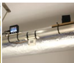
各展示室に設置した、滞在人数や温度、CO 2 などを測るセンサ
