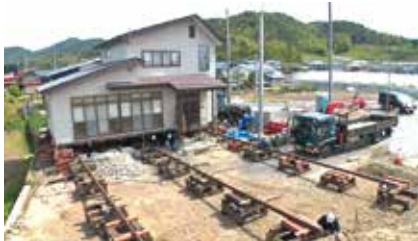
〈研究・技術開発部門〉「日本のチカラ 上げる動かす守る～歴史を支える土木工法・曳家～」(TV)
