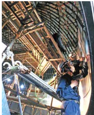
スクリーンの張替え工事中。スクリーンには細かい穴が開いており、天幕の裏側に設置したスピーカーから臨場感溢れるサウンドが降ってきます
