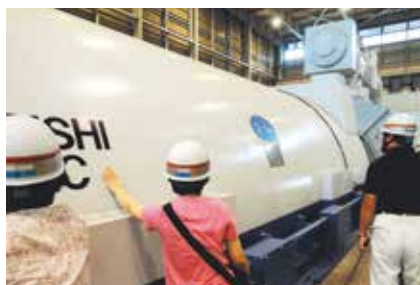
【施設見学会：川崎火力発電所を見学】世界最高水準の熱効率を誇る東京電力(株)の火力発電所。発電機の外側に触れることができます
