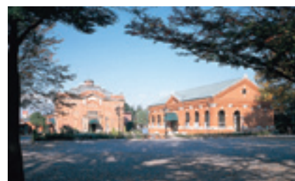
GAS MUSEUM ガスミュージアム
