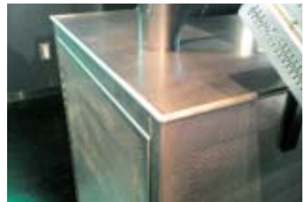
【展示品部の安全対策と耐久性対策】 展示品上部の角に丸鋼を取りつけて、当たりをやわらげるようにしている。また、触られる部分を塗装仕上げにせずに、ステンレス材(パーマネントヘアーライン仕上)で仕上げることによって、剥げや錆びを防止している
