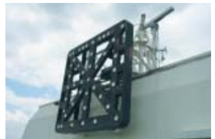
【東京港内交通管制信号機】 館内にある東京港内交通管制室からコントロールされている信号機。船の科学館以外にも東京湾内に6か所ある
