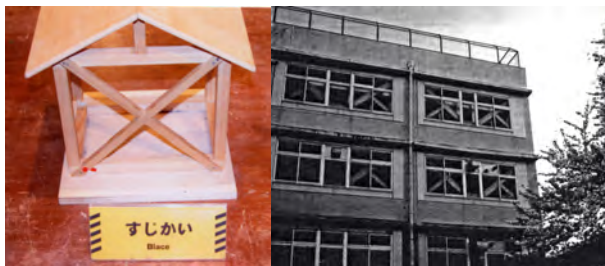
写真9 モデル用すじかいと学校教室の耐震ブレース
