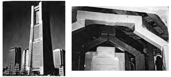
写真3 ランドマークタワーとタワー最上階の振り装置 (340トン)
